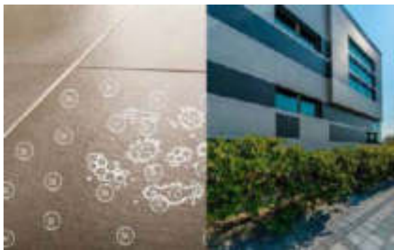
CERAMICHE ACTIVE SURFACES IMPIEGATE COME ELEMENTI ARCHITETTONICI CON PROPRIETÀ AUTOPULENTI E AUTOSTERILIZZANTI.
